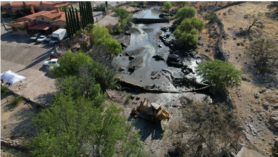
Una excavadora derriba un muro de las presas ilegales halladas en un rancho del exgobernador de Chihuahua, César Duarte. Gobierno de México
